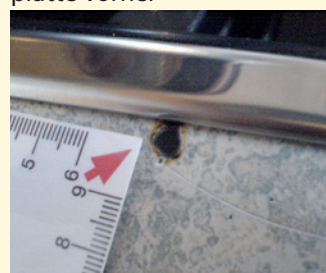
Sengschaden Küchenarbeitsplatte vorher
