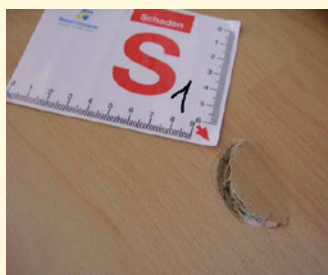
Einkerbung Laminatboden vorher
