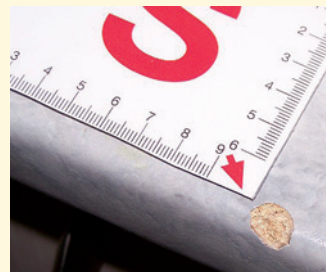
Einkerbung Küchenarbeitsplatte vorher
