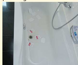
Schlagschäden durch Vasen
