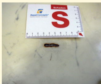
Sengschaden im PVC-Boden vorher
