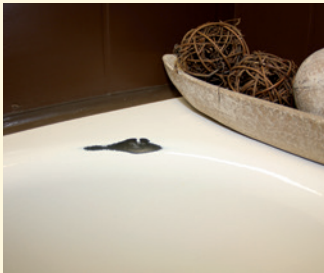
Massiver Schlagschaden (Emailleabplatzung) vorher
