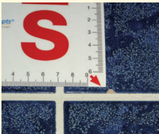
Materialausbruch Fliese vorher
