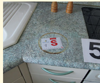
Kreisrunder Sengschaden vorher
