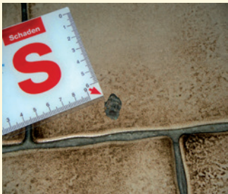
Loch in Fliese vorher
