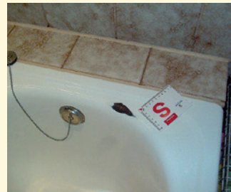
Schlagschaden/Emailleabplatzung Wannenrand
