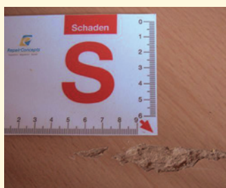
Einkerbung Laminatboden - vorher
