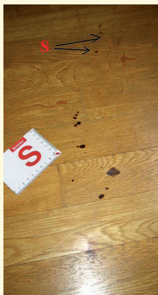
Sengschäden Parkettboden vorher
