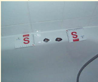
2 Schlagschäden (Emailleabplatzung) Wannenrand vorher
