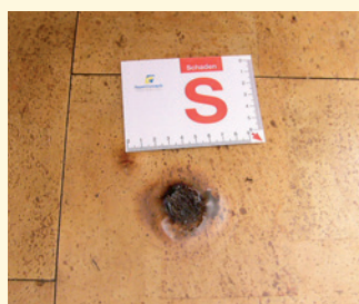
Sengschäden Korkboden vorher
