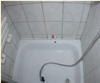
Schlagschaden (Emailleabplatzung) Duschtasse vorher
