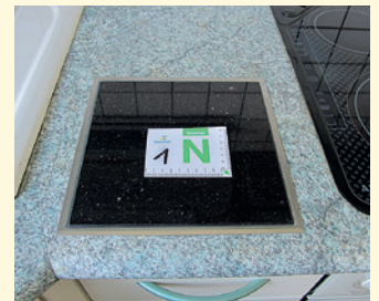
Einbau Granitschneidfläche nachher
