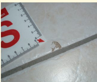
Materialausbruch Fliese vorher
